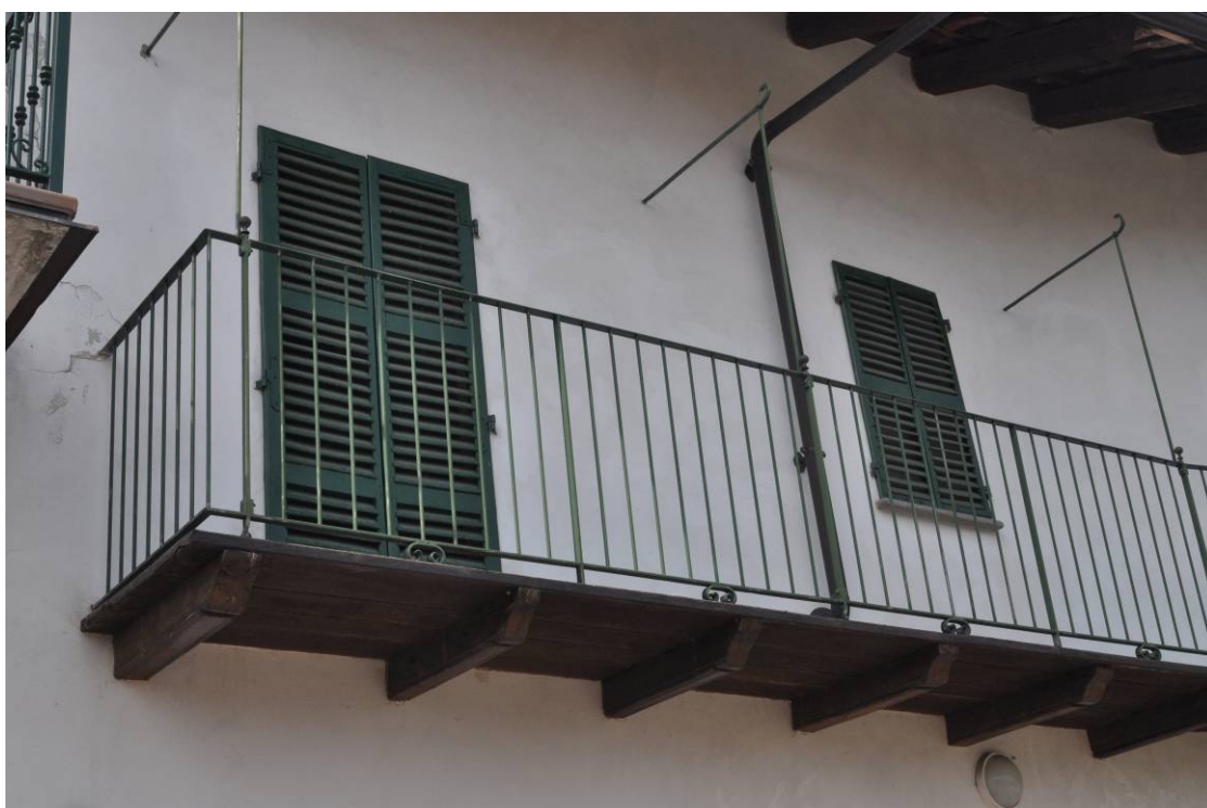
ESEMPIO DI RINGHIERA ALLA PIEMONTESE E DI BALCONE IN LEGNO
